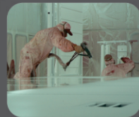
Cabina de pintura y horno de secado.
